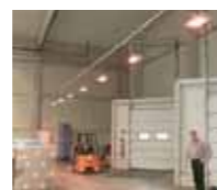
Halls (production, entrepôt, etc.)
