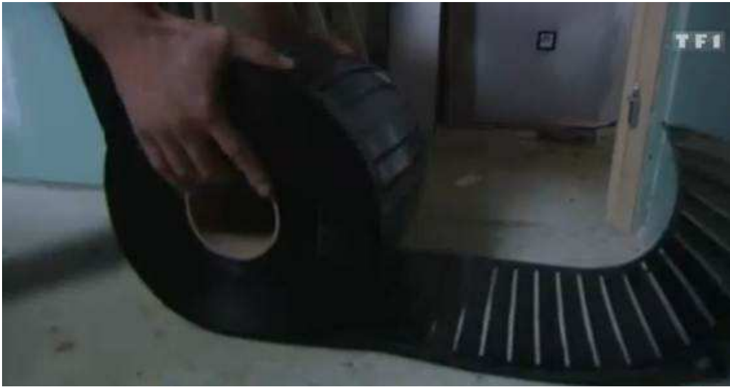
Le chauffage STEP WARMFLOOR 24 volts est déroulé sur le sol
