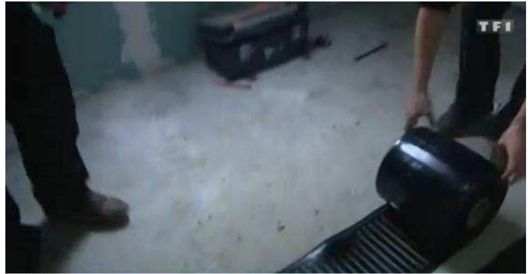
Ensuite, il sera recouvert par le carrelage et deviendra invisible
