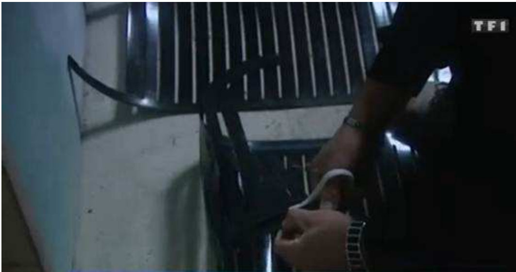
Connection des éléments chauffants par l'électricien
