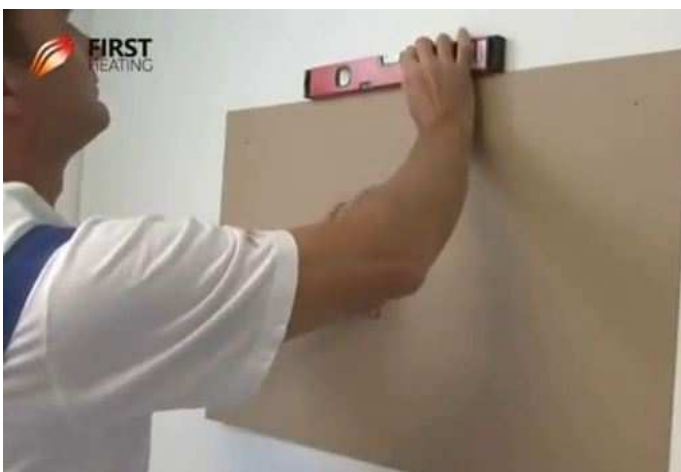
Mise à niveau du gabarit
