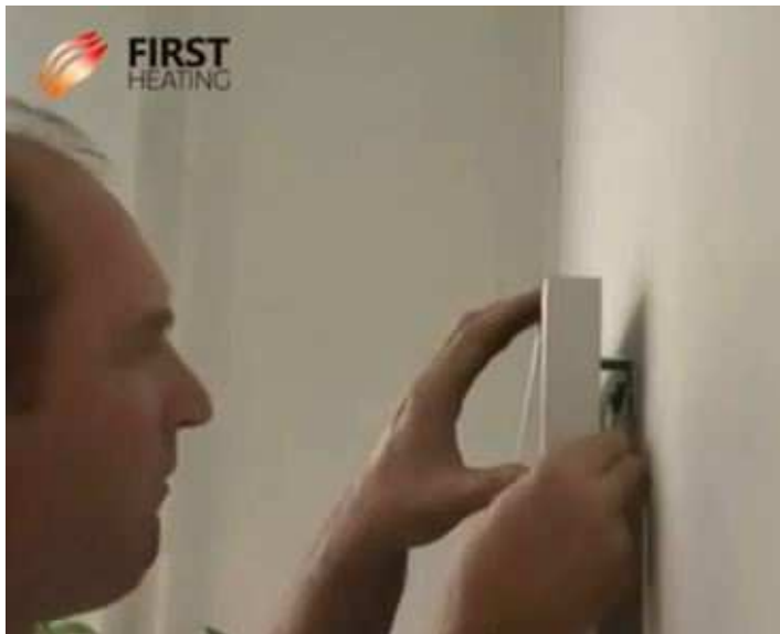
Serrage des vis derrière le panneau
