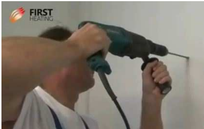
Perçage du mur
