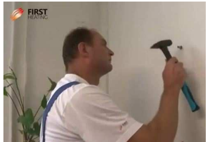
Mise en place des chevilles
