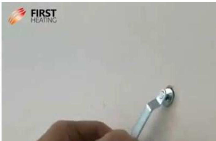
Mise en place des vis et rondelles
